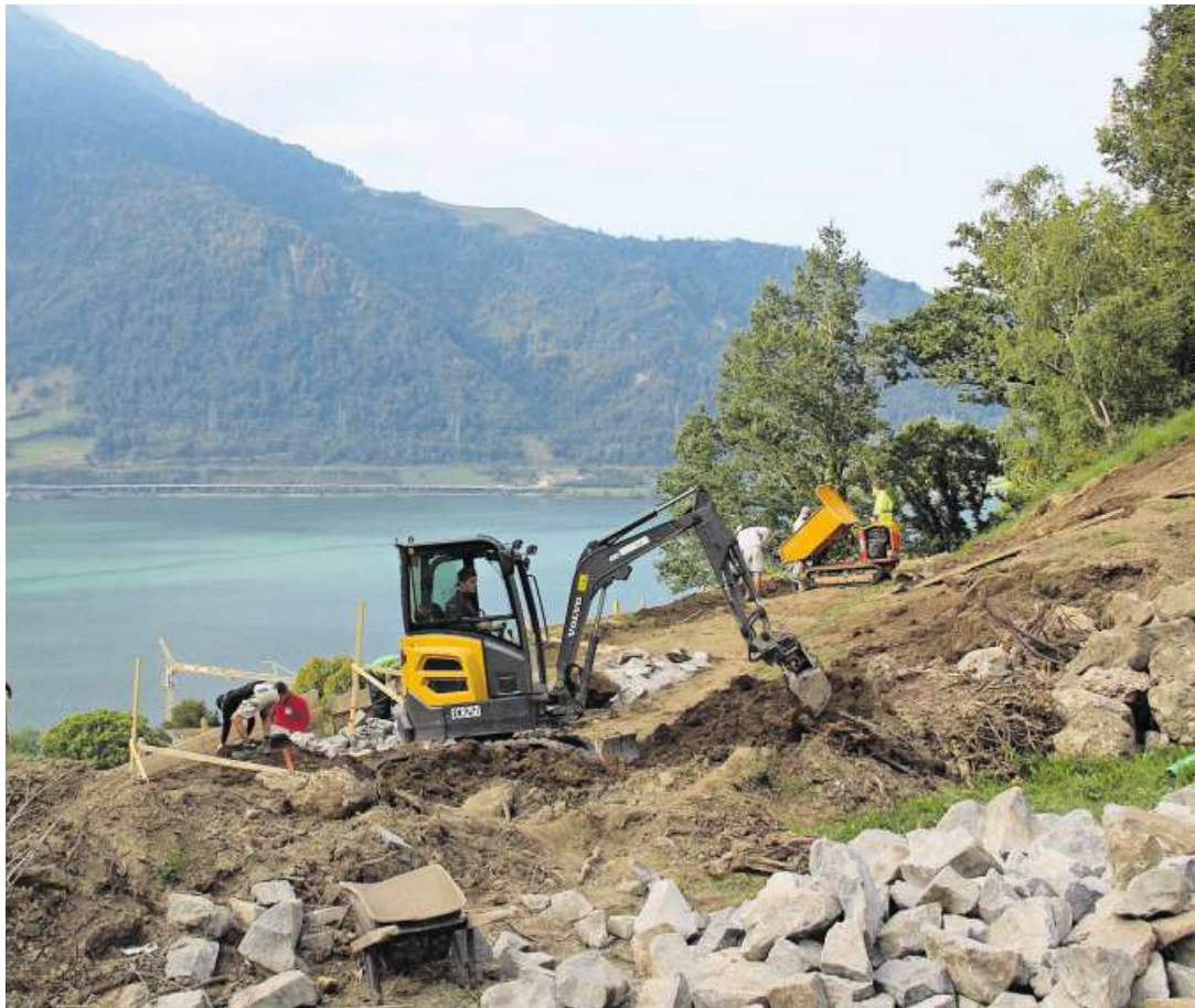
Oberhalb des Zentrums Elisabeth in Walchwil haben 15 Maurerlehrlinge im 3. Lehrjahr eine Trockenmauer gebaut. Organisiert wurde die Projektwoche vom GIBZ. Das Vorhaben wurde auch von den Zuger Bauunternehmen mitgetragen. Sie haben im Betrieb eine Woche lang auf ihre Lehrlinge verzichtet.
